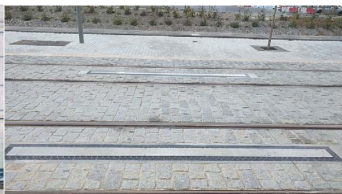
Plaque de rechargement rapide en station. (photo wikipédia)
