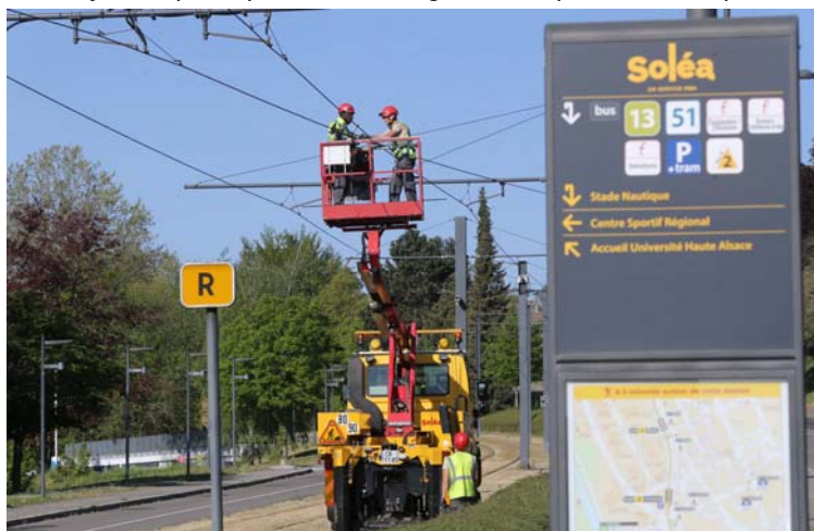
Les techniciens de la maintenance de Soléa travaillent sur la ligne 2 du tram. Photo L'Alsace /Jean-François FREY
